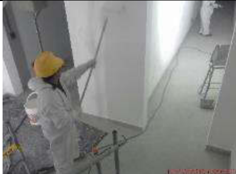
Foto 12.- 10/12/2019. Pintado de las paredes de los cuartos planta cables.
