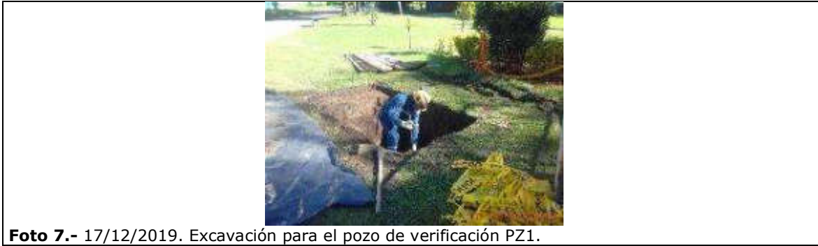
Foto 7.- 17/12/2019. Excavación para el pozo de verificación PZ1.
