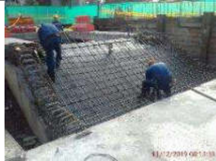
Foto 10.- 11/12/2019. Armado de acero del recrecido del acceso 1.
