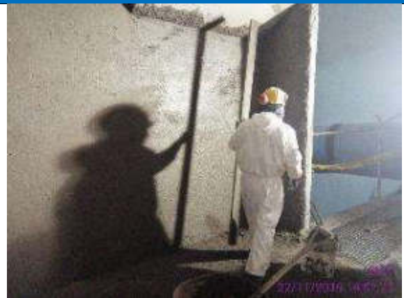
Foto 2.- enfoscado de mampostería en zona de jets
