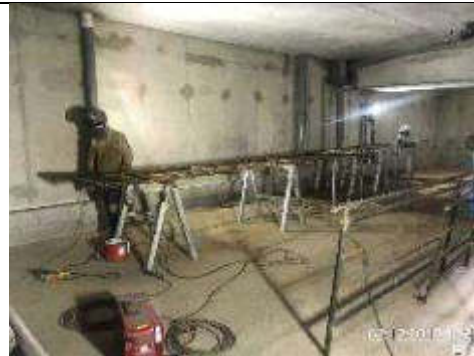
Foto 7.- Fabricación de pasamanos metálicos escaleras salida de emergencia andén comunicaciones.
