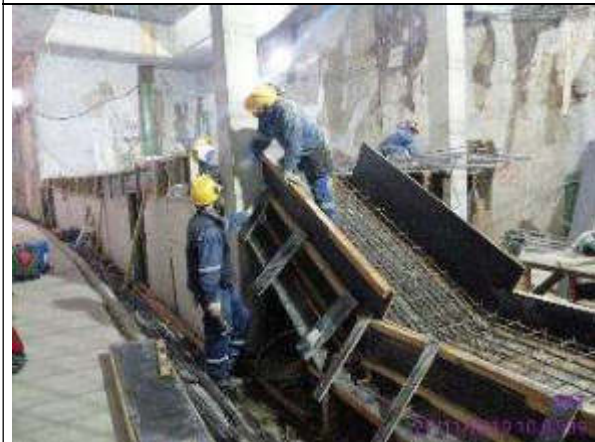
Foto 5.-. armado de acero de tramo 1 de gradas en zona jets
