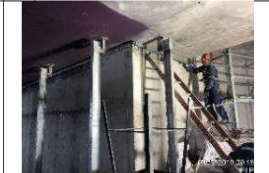
Foto 10.- Montaje de tubería de descarga bombeo fecales a nivel de acceso #2.
