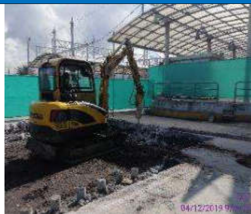
Foto 2.- picado de pavimento en el acceso 3
