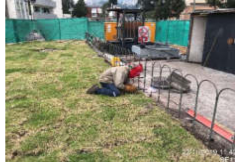
Foto 4.- Reparación en soldadura en cerramiento perimetral de jardineras en plaza Indoamérica.
