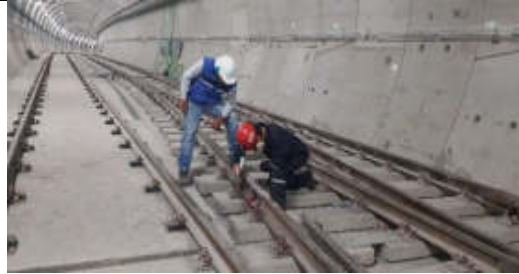
FOTO 09: 05-12-19. Verificación de la soldadura mediante tinta penetrante en la diagonal 8.
