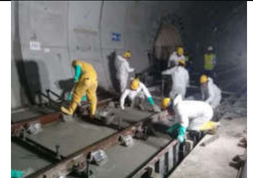
FOTO 12: 12-11-19. Hormigonado de la vía en el PB3.
