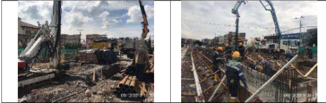
Foto 4.- Perforación de micro pilotes en cañón de acceso #6 salida dársena Seminario Mayor.
