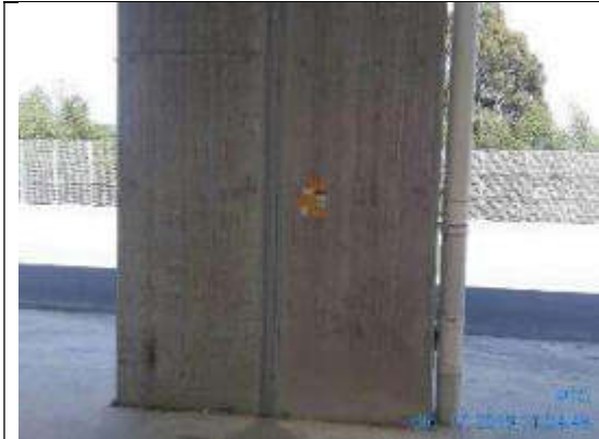
Foto 33.- Sellado de juntas de pilares en módulo #1.
