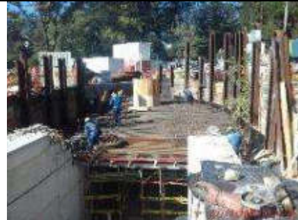
Foto 4.- 02/12/2019. Armado de acero de la losa de cubierta del acceso 1.
