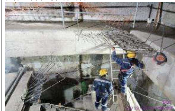
Foto 17.- enderezado de esperas de losa en zona jets
