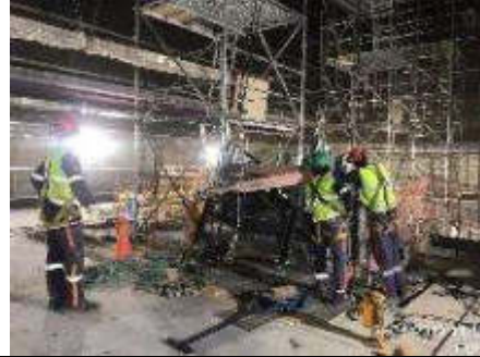
Foto 3.- Montaje de escalera mecánica nivel losa de vestíbulo a losa de mezzanina cabecera norte.
