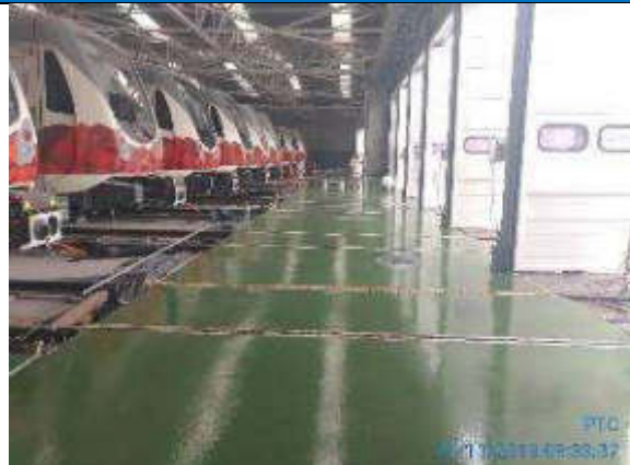
Foto 2.- Trabajos de TEIMPAV en área de estacionamiento.
