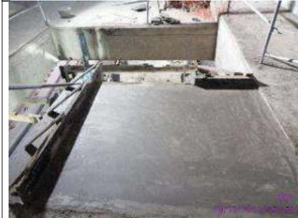
Foto 21.-. hormigonado de tramo 4 de gradas de zona jets
