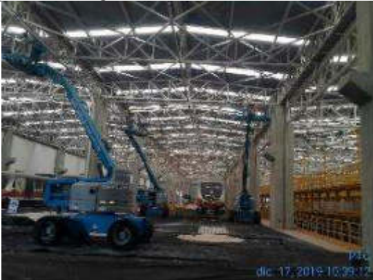
Foto 31.- Trabajos de reparación de pintura de estructura metálica de cubierta.
