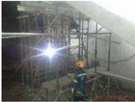
Foto 5.- 29/11/2019. Retiro de cimbra de las escaleras del acceso 3.
