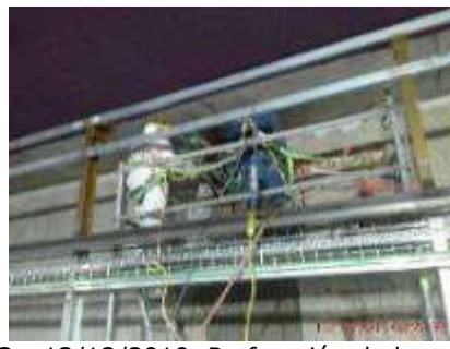
Foto 12.- 13/12/2019. Perforación de la pantalla del pasillo del acceso 1 tubería del pozo bombeo.
