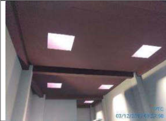
Foto 13.- Trabajos finalizados de pintura en techo, en planta de transformadores de subestación eléctrica.
