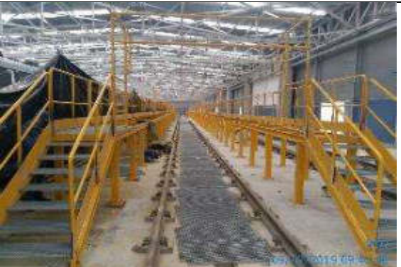
Foto 18.- Montaje de estructura metálica en vías de estacionamientos.
