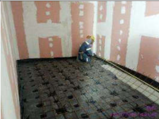
Foto 17.- colocación de cupolex y malla en cuarto acom. Eléctrica en entreplanta
