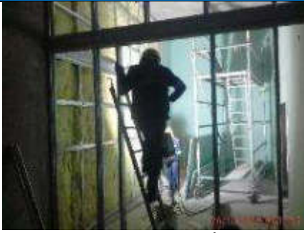
Foto 1.- 26/11/2019. Colocación de gypsum piso techo de los baños a nivel del vestíbulo.
