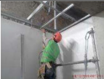
Foto 13.- 14/12/2019. Instalación de cielo falso a nivel de vestíbulo lado este de la estación.
