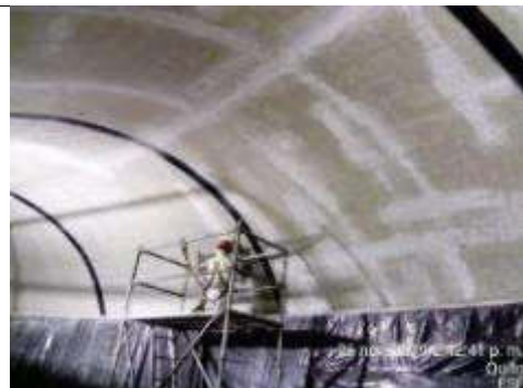
Foto 6.- 26/11/2019 Tratamiento de juntas en bóveda galería Santa Clara.
