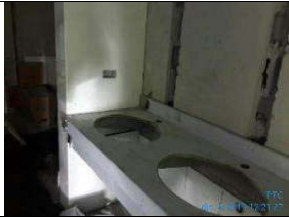
Foto 14.- instalación de encimeras en cuartos de aseo.
