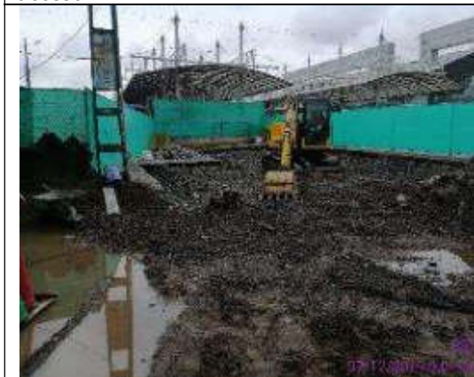
Foto 3.- excavación a nivel de solera en acceso 3
