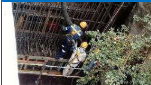
Foto 1.- MURO DE CIERRE RAMPA DE VACIADO
