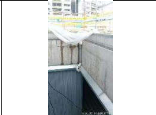
Foto 4.- instalación de sistema de desalajo de desperdicios bomba fecal
