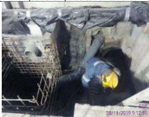
Foto 7.- colocación de tubería de 200mm en arqueta A15
