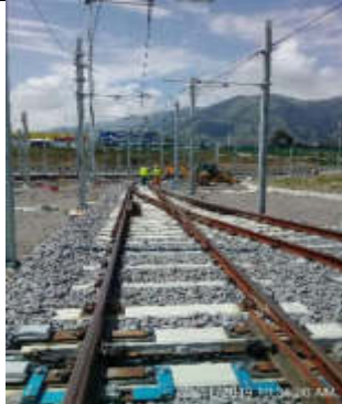
FOTO 03: 30/11/2019. Ajustes en vías sobre balasto de TYC.
