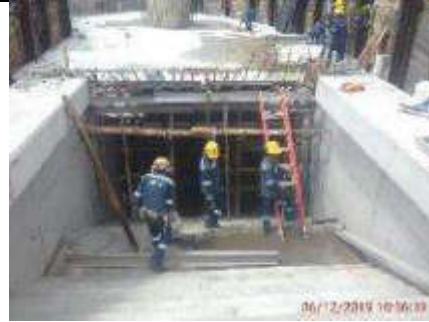
Foto 6.- 06/12/2019. Colocación cimbra para el recredido del acceso 1.
