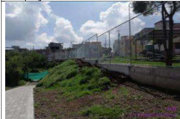
Foto 15.- colocación de malla de cerramiento en urbanización Solidaridad
