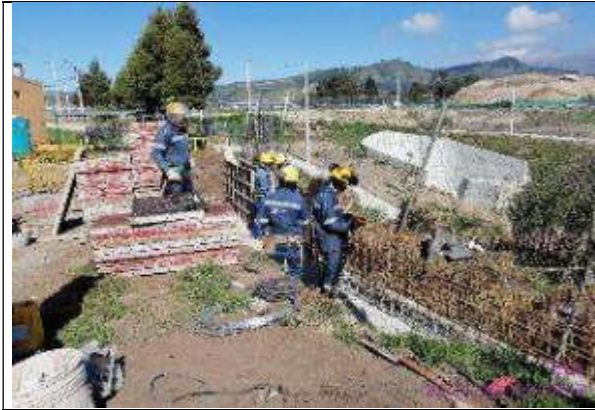
Foto 3.-. armado de malla en muro de cerramiento de urbanización Solidaridad
