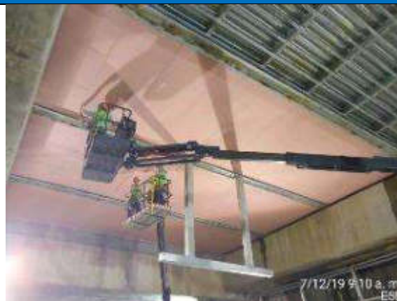
Foto 1.- Colocación de techo de Gypsum bajo la losa de entreplanta ejes 1-2.
