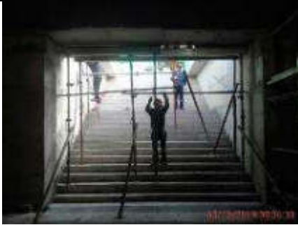
Foto 5.- 05/12/2019. Colocación de cimbra para recredido del acceso 2.
