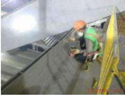
Foto 3.- 03/12/2019. Colocación del soporte inferior de los antepechos de borde de losa
