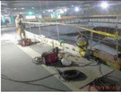
Foto 7.- 07/12/2019. Soldado del soporte inferior de los antepechos de borde de losa.
