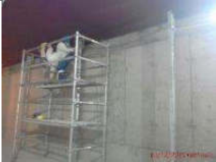
Foto 9.- 10/12/2019. Soldado de la perfilería vertical del pasillo del acceso 1.
