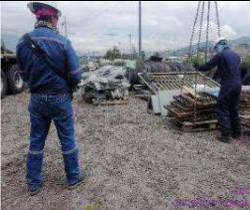
Foto 10.- descarga de material de urbanización Quitumbe en terreno de la EPMPQ.
