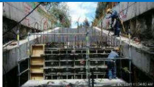
Foto 2.- MURO DE CIERRE RAMPA DE VACIADO
