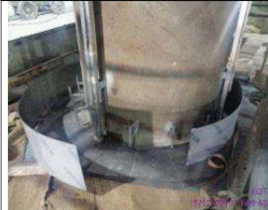
Foto 9.- colocación de chapas- zócalo en pila pilote de andén eléctrico
