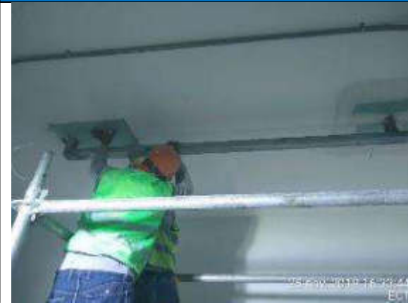
Foto 1.- Colocación de soporte auxiliar perfil galvanizado para sistema contra incendios andén de energía y cuartos de vestidores.
