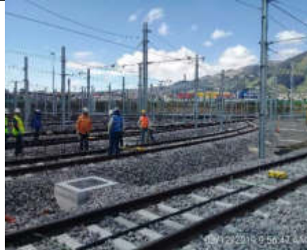
FOTO 04: 03/12/2019. Continúan los ajustes en vías sobre balasto de TYC.
