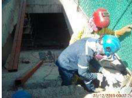
Foto 8.- 03/12/2019. Instalación del precasto del acceso 3.
