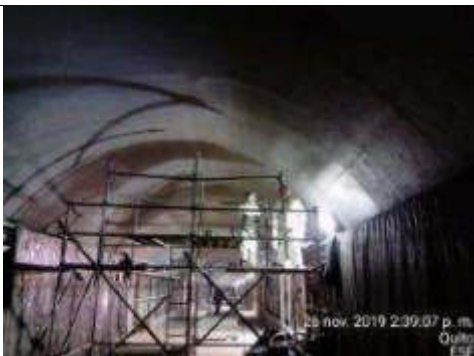
Foto 5.- 26/11/2019. Impermeabilización de bóveda en galería Santa Clara.
