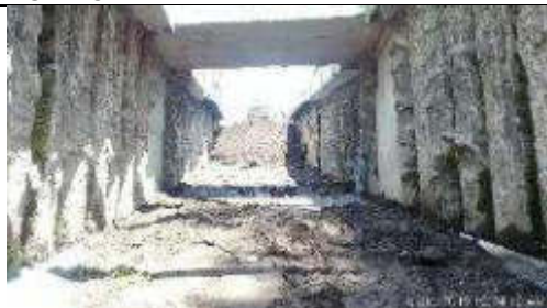
Foto 3.- RELLENO DE RAMPA DE VACIADO
