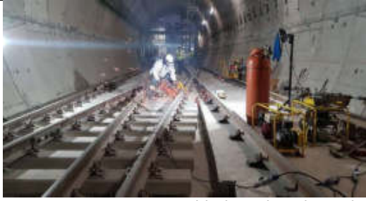
FOTO 07: 04-12-19.- Soldadura de cala ancha en la diagonal 8
