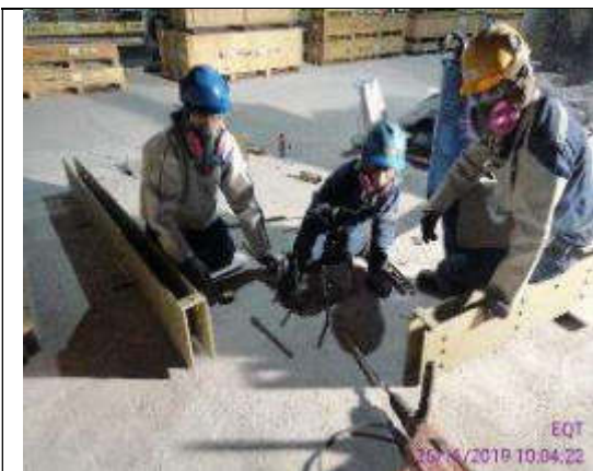
Foto 5.- colocación de zócalo para antepecho en arranque de rampa de comunicaciones
