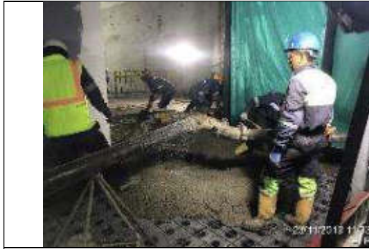
Foto 3.- Vaciado de hormigón 25Mpa en losa de compresión cupolex 9.5 en pasillos losa de entreplanta.
