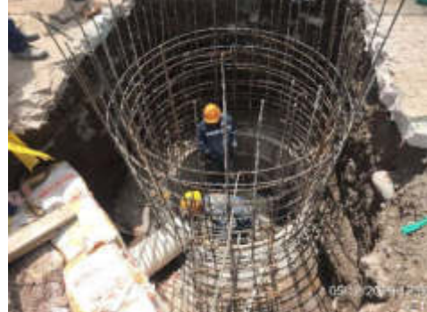
Foto 2.- Armadura estructural pozo Z2 TIPO J, conexión con red de saneamiento existente.
