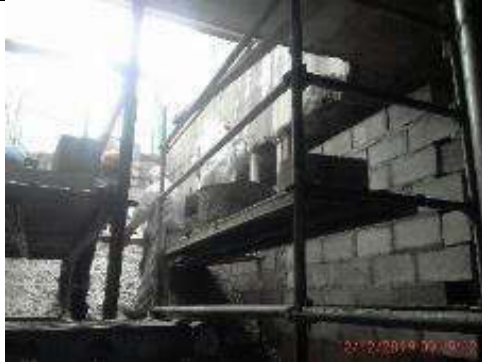
Foto 13.- 12/12/2019. Colocación del bloque de la mampostería del acceso 3.
