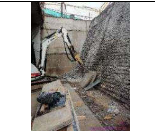
Foto 4.- picado de muro para posterior colocación de micropilotes en acceso 4
