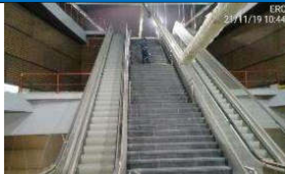
Foto 1.- Colocación de tubería inoxidable para barandillas fijas en escaleras entre Losa de Vestíbulo y Mezzanina.
