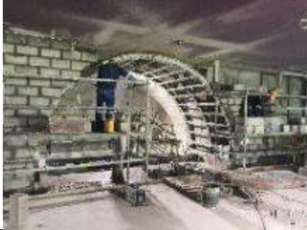
Foto 2.- Colocación de bloque en mampostería de emboCADURAS acceso galerías andén desde losa de mezzanina.
