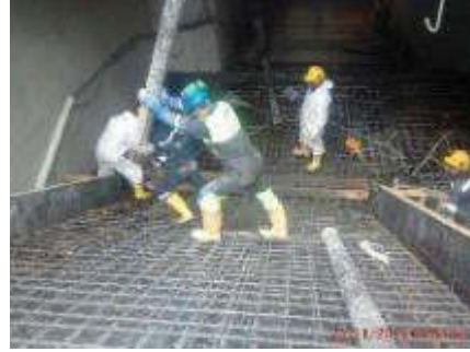
Foto 2.- 23/11/2019. Hormigonado de las escaleras del acceso 3.
