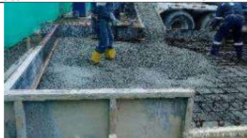
Foto 8.- CIERRE DE VENTANA EN LOSA DE CUBIERTA
