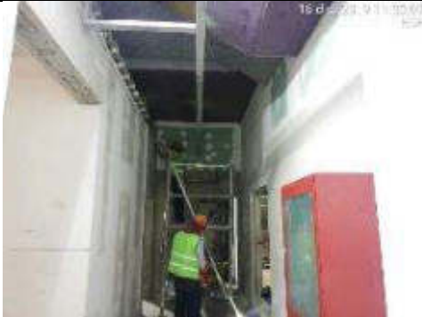
Foto 27.- 16/12/2019. Colocación Gypsum para remate superior de mampostería en entreplanta.
