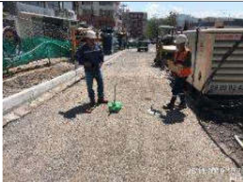
Foto 2.- Ensayo de compactación en relleno con material de mejoramiento a nivel rampa de vaciado, calle Antonio de Marchena.
