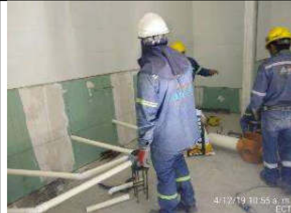
Foto 3.- Colocación y conexión de tubería para el sistema de saneamiento baños nivel vestíbulo.
