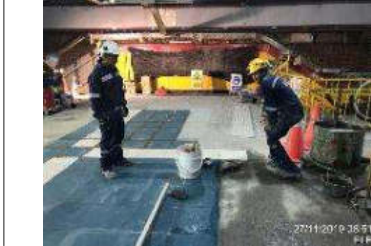
Foto 5.- Colocación de porcelanato Alcalgres a nivel losa de mezzanina.
