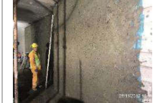
Foto 6.- Enfoscado de mampostería cuartos eléctricos nivel rampa de vaciado.
