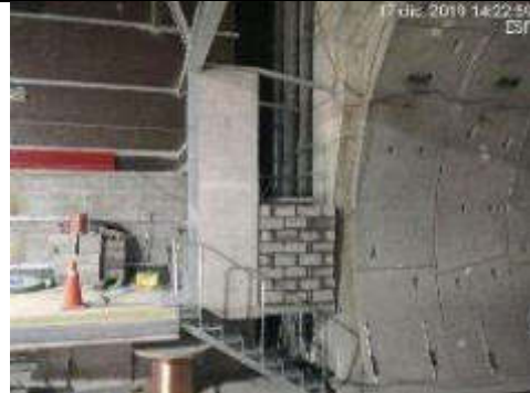
Foto 28.- 17/12/2019. Mampostería de bloque en piñón sur a nivel de andén.
