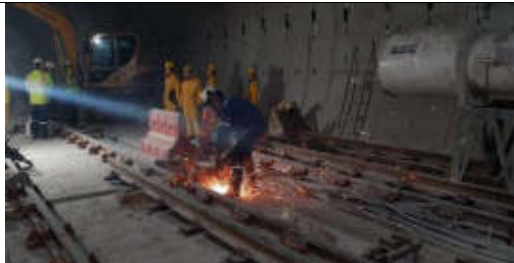
FOTO 05: 04-12-19.- Corte de rieles en la zona de tratamiento, tramo Solanda - Cardenal de la Torre, para la reposición de vía y mejoramiento de nivelación.
