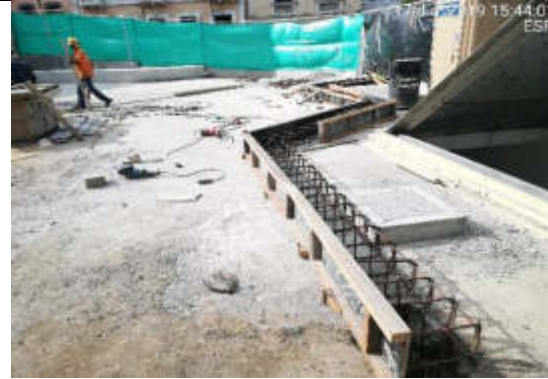
Foto 1.- Encofrado de cadena base para cerramiento perimetral.
