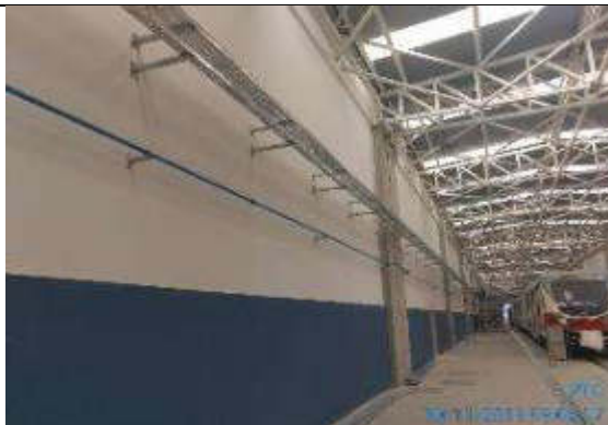
Foto 11.- Colocación de bandejas en ejes divisorios.
