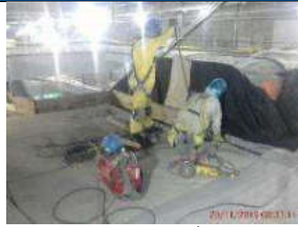
Foto 2.- 23/11/2019. Colocación del soporte inferior de los antepechos de borde de losa a nivel de vestíbulo.
