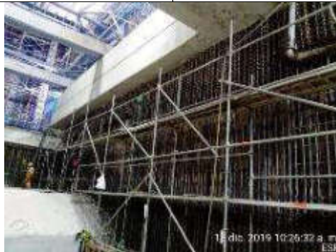
Foto 29.- 18/12/2019. 2do tramo de Armadura para muro forro desde ESF a CBP.
