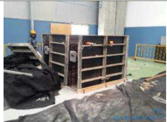
Foto 20.- Trabajos de encofrado de topera de vía #1.
