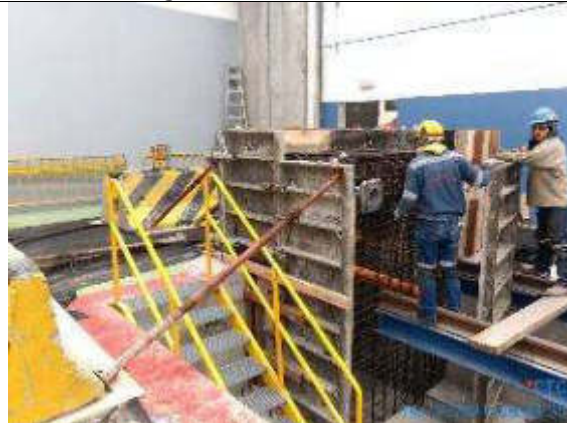
Foto 26.- Trabajos de encofrado de topa de vía #2.
