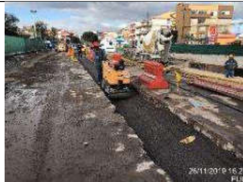
Foto 3.- Relleno y compactación en zanja desvío de tubería red de abastecimiento Av. América sector dársena Seminario Mayor.
