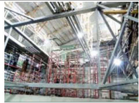
Foto 18.- 09/12/2019. Armado de cimbra para losa
