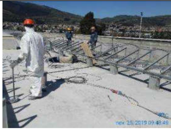
Foto 6.- Trabajos de impermeabilización de cubierta de edificio administrativo.
