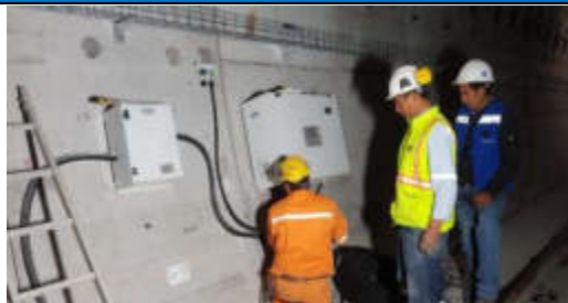
FOTO 01: 22-11-19.- Instalación de las cajas eléctricas para los engrasadores.
