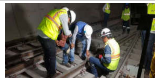
FOTO 06: 04-12-19.- Soldadura de cala ancha en la diagonal 8
