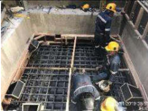
Foto 4.- Montaje de armadura estructural losa foso de ascensor acceso a superficie a nivel losa de vestíbulo.
