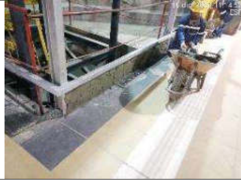
Foto 26.- 16/12/2019. Remate de rodapié en ascensores a nivel de vestíbulo.
