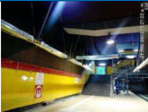
Foto 1.- 21/10/2019. Colocación de luminarias en andén.
