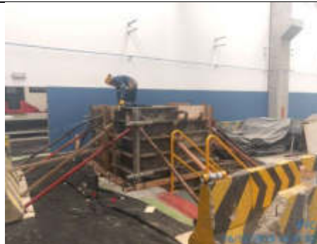
FOTO 06: 16/12/2019. Nave de Talleres. Hormigonado de topera de vía 2
