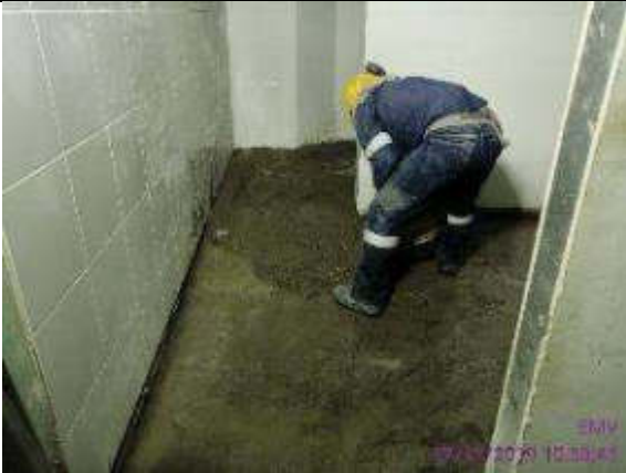
Foto 15.- vaciado de plastón em aseos de entreplanta
