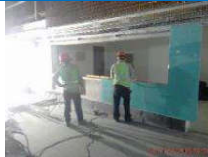
Foto 2.- 26/11/2019. Instalación de vitrex a nivel del vestíbulo.
