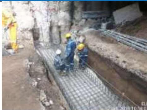
Foto 1.- Armado de acero para zapata de muro de cierre de rampa de vaciado
