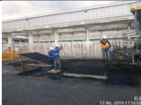
Foto 6.- Asfalto de superficie de boca de salida de emergencia
