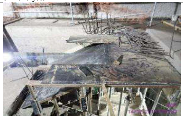
Foto 18.- armado de encofrado para tramo 4 de gradas de zona jets
