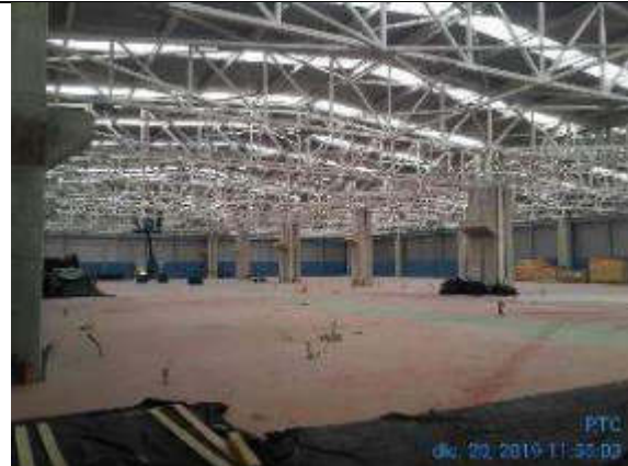
Foto 38.- Trabajos de reparación de pintura de estructura metálica de la cubierta del módulo 11.
