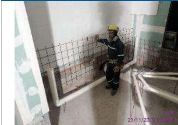
Foto 3.- colocación de malla para muro perimetral de cuplex Rialto en aseos de entreplanta
