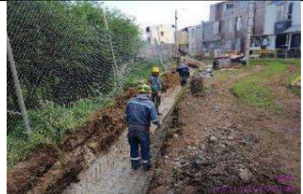
Foto 8.- armado de malla de zapata en urbanización Solidaridad 2
