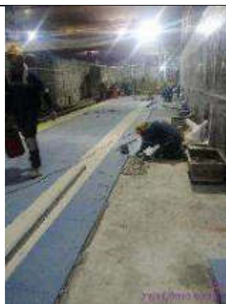
Foto 6.- colocación de gres porcelánico en andén eléctrico
