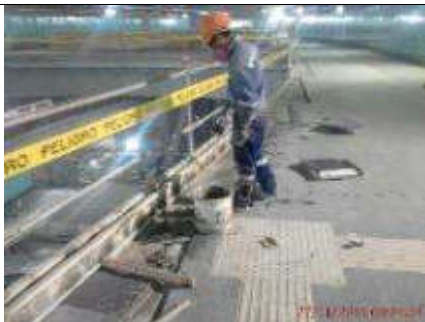
Foto 3.- 27/11/2019. Instalación de gres porcelánico a nivel del vestíbulo.
