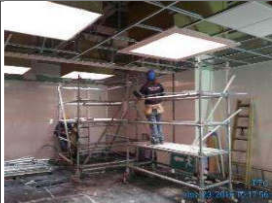
Foto 5.- Colocación de perfilería para montaje de falso techo en planta alta de edificio administrativo.
