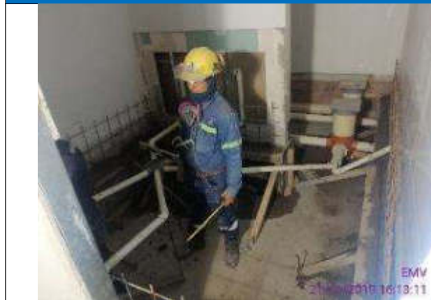
Foto 1.- hormigonado de muro perimetral par cupolex Rialto en aseos de entreplanta
