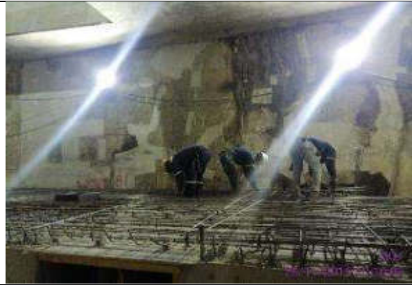
Foto 4.- armado de acero de losa en zona jets
