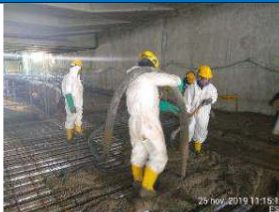
Foto 2.- Vaciado de hormigón de la losa de vestíbulo ejes 2-3, V=32 m3 sobre forjado mixto.
