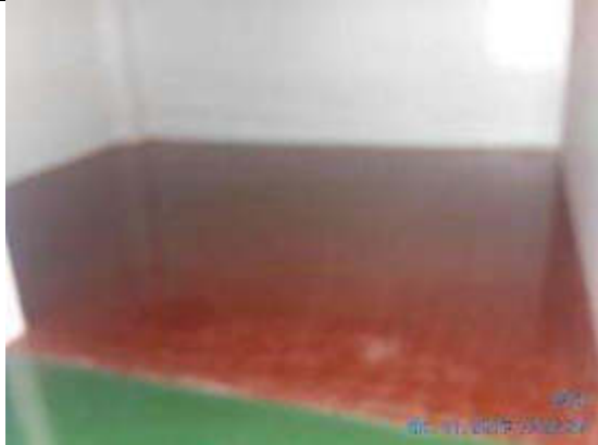
Foto 21.- Trabajos de TEIMPAV en cuartos técnicos.
