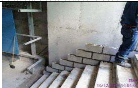
Foto 22.- levantamiento de mampostería de bloque en gradas de acceso 2
