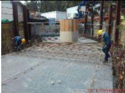
Foto 3.- 27/11/2019. Armado de acero de la losa de cubierta del acceso 1.
