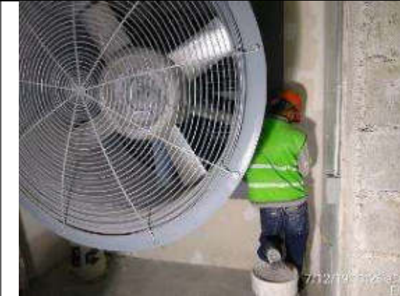
Foto 4.- Colocación y sellado de panel fibrosilicato en estructura de ventilador andén comunicaciones.
