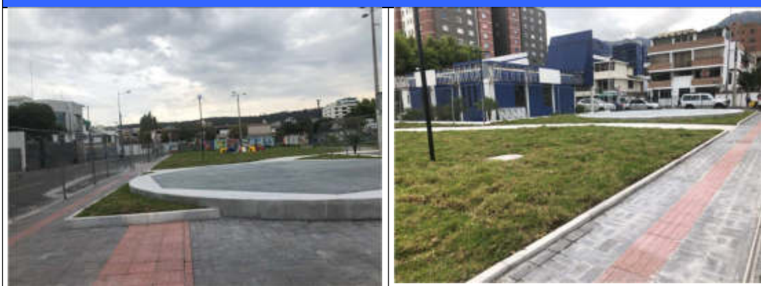
Foto 1.- Urbanización del área afectada.
