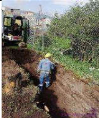
Foto 7.-. excavación para zapata de muro cerramiento de urbanización Solidaridad
