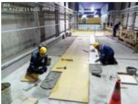
Foto 7.- 27/11/2019 Colocación de solado en entronque San Francisco.
