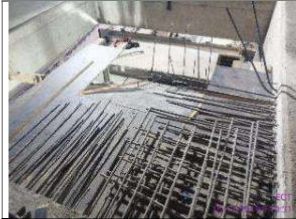
Foto 19.-. armado de acero para tramo 4 de zona jets
