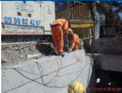
Foto 1.- 18/12/2019. Instalación del precurso del acceso 1.
