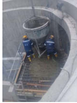
Foto 4. Hormigonado de losa de presurización
