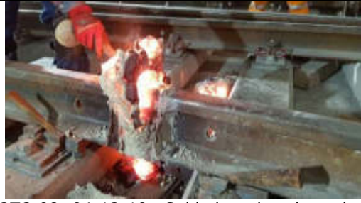
FOTO 08: 04-12-19. Soldadura de cala ancha en la diagonal 8
