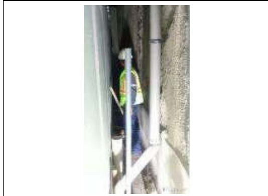
Foto 3.- instalación de sistema de desalajo de desperdicios bomba fecal
