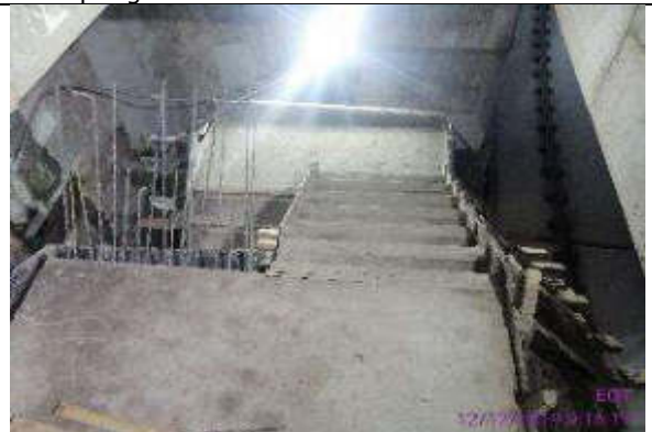
Foto 16.- hormigonado de tramo 2 y 3 de gradas en zona jets
