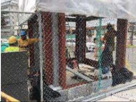
Foto 1.- Montaje y soldadura de casetón de ascensor nivel superficie Av. Eloy Alfaro Inglaterra. Foto 2.- Ensayo de densidades en tendido de carpeta asfáltica pavimento de rodadura Av. Eloy Alfaro.
