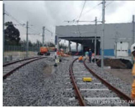
FOTO 02: 29/11/2019. Colocación de bridas en las juntas de carriles de las vías sobre balasto.
