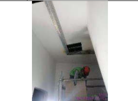
Foto 8.- colocación de tubo de 80x40x3 para soporte de nebulizadores
