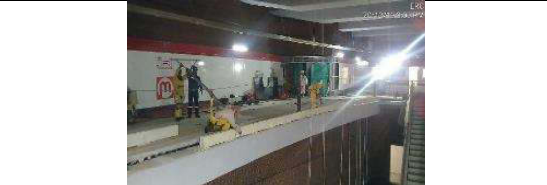
Foto 3.- Perforaciones y presentación de Zócalos Bajo de Borde en Losa de Vestíbulo Lado Oeste.
