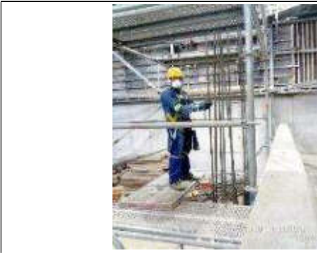
Foto 13.- 03/12/2019. Armadura de columna redonda soporte de losa.
