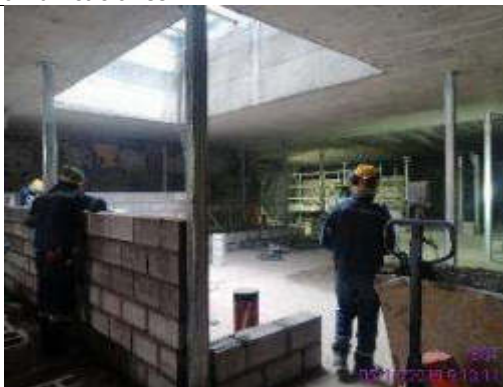
Foto 11.- levantamiento de mampostería de bloque en cuarto de ventilación
