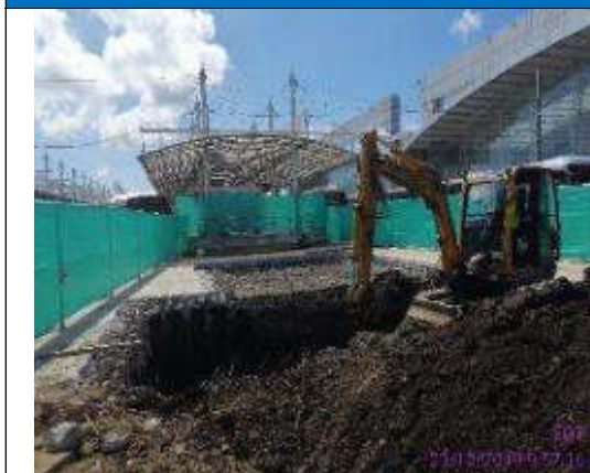
Foto 1.- excavación a nivel de solera en el acceso 2
