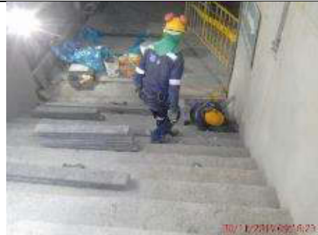
Foto 6.- 30/11/2019. Instalación de granito en el acceso 1.
