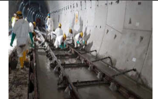
FOTO 11: 11-12-19. Hormigonado de la vía 2 izquierda, en el tramo de reposición Solanda - Cardenal de la Torre.
