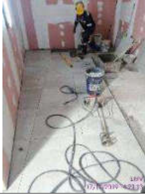
Foto 23.- colocación de porcelanato en cuarto acom. eléctrica
