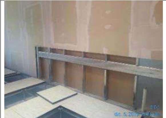
Foto 15.- Montaje de viga para sujeción de encimeras y aparatos sanitarios.
