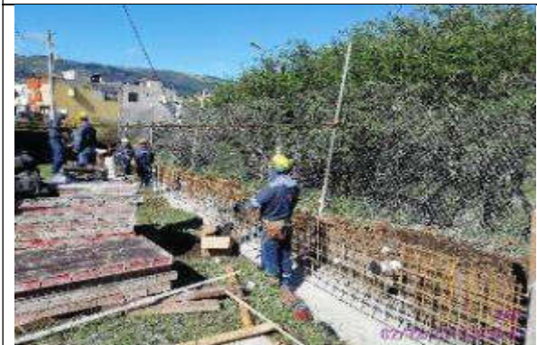
Foto 9.-. armado de malla en muro de cerramiento de urbanización Solidaridad
