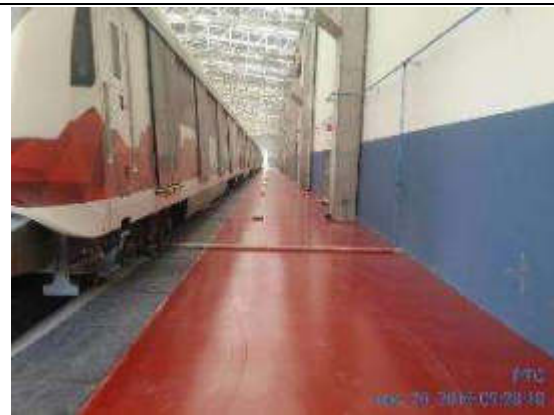
Foto 10.- Trabajos de TEIMPAV en área de mantenimiento.
