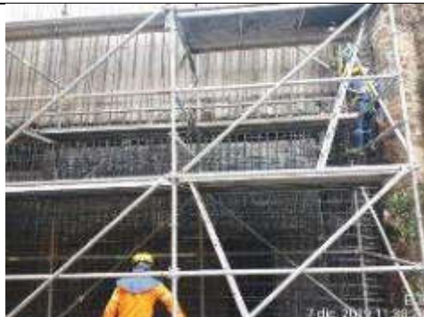
Foto 3.- Armado de acero para muro de cierre de rampa de vaciado
