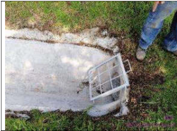
Foto 11.- colocación de rejilla en cal de descarga hacia quebrada en urbanización Solidaridad
