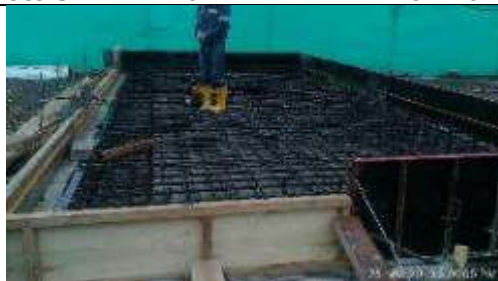
Foto 7.- CIERRE DE VENTANA EN LOSA DE CUBIERTA
