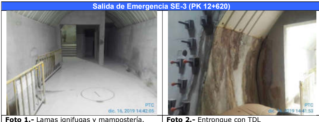
Foto 1.- Lamas ignífugas y mampostería.
