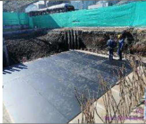
Foto 6.- colocación de encofrado para losa de cubierta de acceso 2
