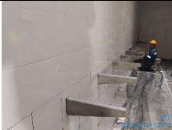
Foto 23.- Montaje de apoyos para encimeras en cuartos de baños.
