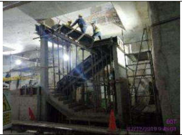
Foto 12.- armado de encofrado de tramo 2 y 3 de gradas en zona jets
