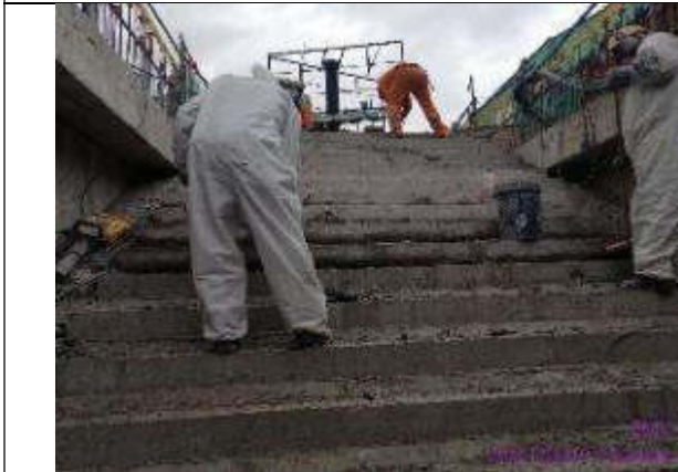
Foto 7.- resane y reparación de filos de gradas de acceso 3, previo al evento por fiestas de Quito
