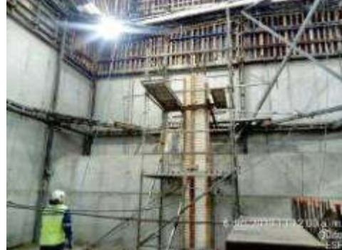
Foto 16.- 06/12/2019. Encofrado de columna soporte de losa.
