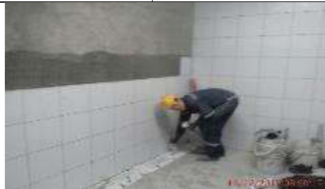
Foto 15.- 18/12/2019. Instalación de cerámica en las paredes de los baños a nivel del vestíbulo.
