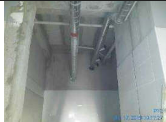
Foto 30.- Instalación de ductos de ventilación en planta baja y alta de edificio administrativo.
