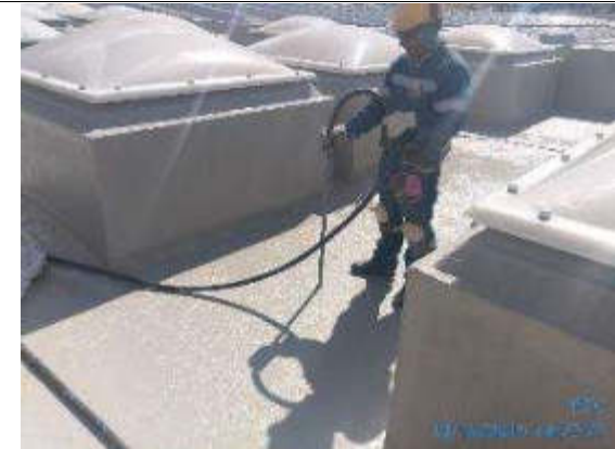
Foto 24.- Se realiza perforaciones en losa de cubierta de edificio administrativo para eliminar agua atrapada entre el mortero de pendientes y losa de hormigón.
