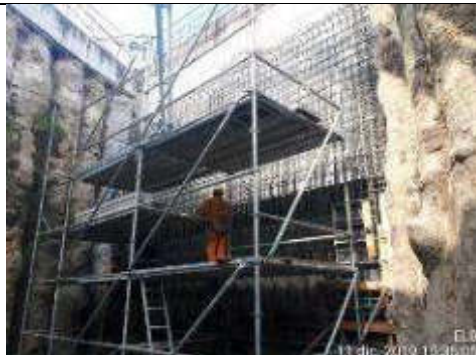
Foto 4.- Hormigonado de fase 1 de muro de cierre de rampa de vaciado
