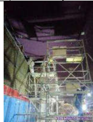
Foto 18.- Perforaciones en techo andén anclajes de la estructura de conducto de ventilación
