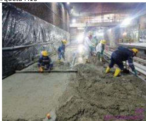
Foto 9.- vaciado de plastón en anden de comunicaciones
