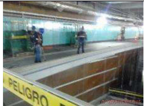
Foto 17.- 17/12/2019. Instalación del vidrio de los antepechos de borde de losa a nivel del vestíbulo.
