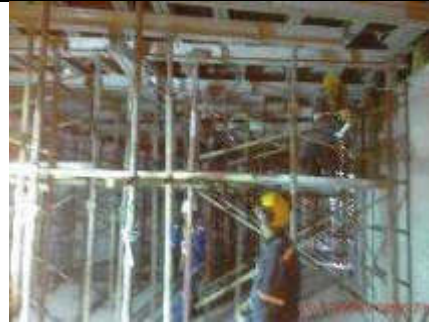
Foto 8.- 09/12/2019. Retiro de la cimbra de la losa de cubierta del acceso 1.
