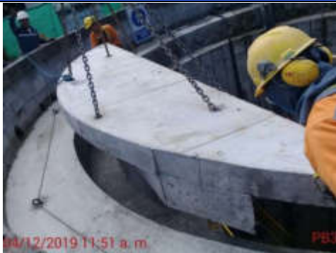
Foto 1. Colocación de las vigas de cierre del pozo.
