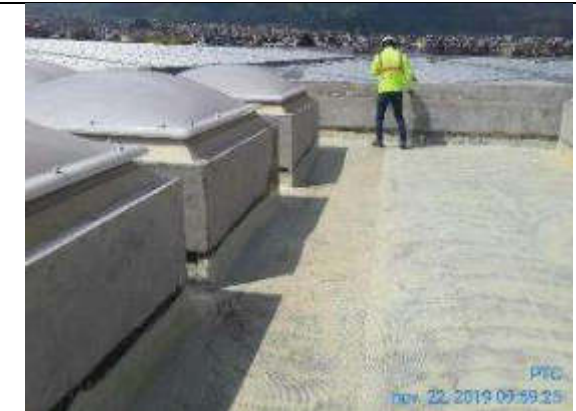
Foto 4.- Trabajos de impermeabilización de cubierta de edificio administrativo.
