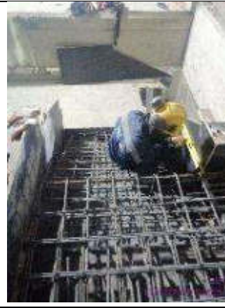
Foto 20.- encofrado lateral del tramo 4 de zona jets
