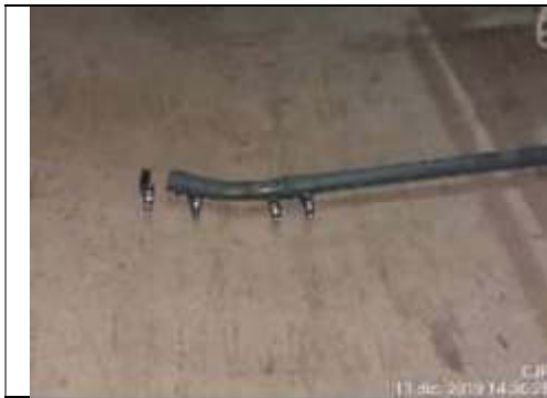
Foto 19.- Colocación de tubería para bombeo de fecales
