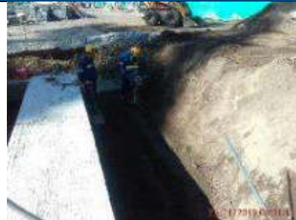
Foto 2.- 25/11/2019. Relleno y compactación de los muros laterales del acceso 2.
