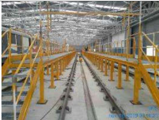
Foto 7.- Montaje de estructura metálica en vías de estacionamientos.
