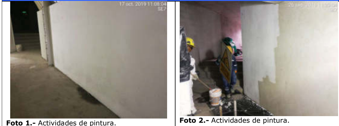
Foto 1.- Actividades de pintura.
