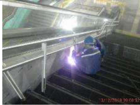
Foto 14.- 13/12/2019. Instalación de pasamanos de las escaleras tramo losa andén a losa de vestíbulo.
