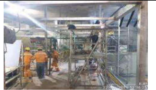
Foto 2.- Colocación de perfilería en zona de circulación de salida de emergencia
