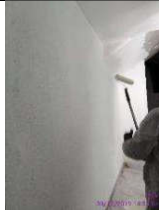
Foto 16.- primera mano de pintura, en salida de emergencia - pasillo zona de jets
