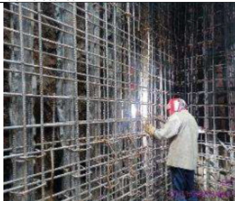
Foto 8.- soldado de omegas en pilotes de muro forro de salida de emergencia
