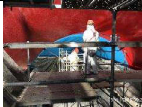
Foto 5.- Impermeabilización de bóveda de hormigón en galerías acceso andén comunicaciones con sistema Teimlam.
