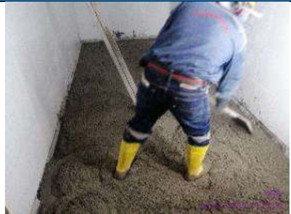
Foto 4.- hormigonado de capa de compresión de vestidores en entreplanta
