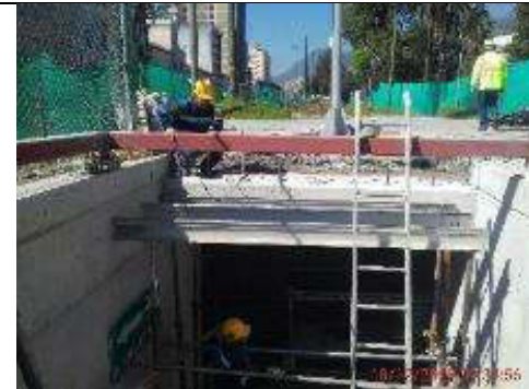
Foto 18.- 18/12/2019. Armado de cimbra para recrecido de la boca del acceso 2.
