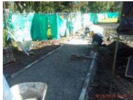
Foto 4.- 19/12/2019. Instalación de adoquín para reposición del parque.
