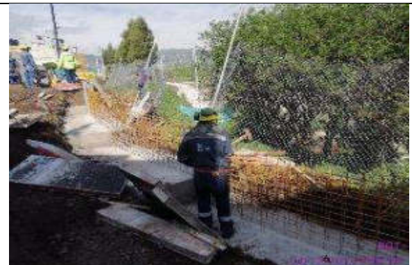
Foto 10.- armado de malla en muro de cerramiento de urbanización Solidaridad
