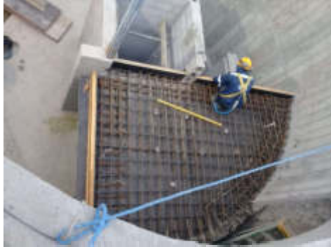
Foto 3. Armado de acero losa de presurización.
