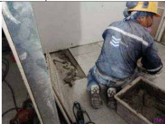
Foto 14.- colocación de porcelanato en aseos de entreplanta
