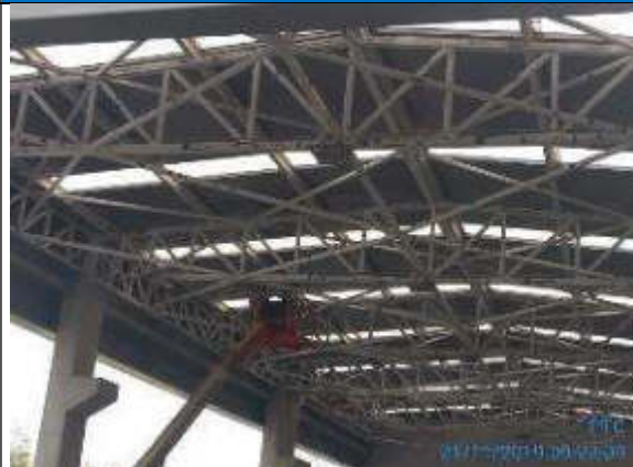
Foto 1.- Trabajos de reparación de pintura de estructura metálica de cubierta.
