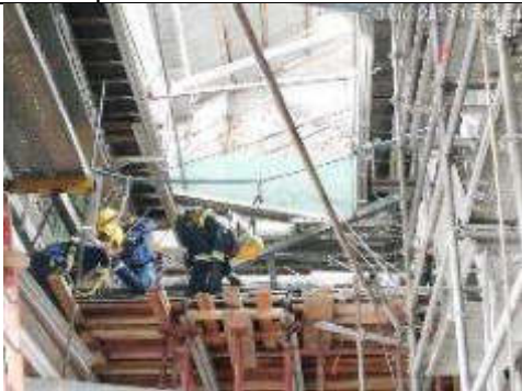
Foto 19.- 10/12/2019. Armado de losa intermedia y colocación de pasa tubos.
