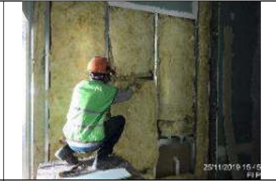
Foto 4.- Colocación de aislante lana de vidrio en tabiquería drywall en cuartos vestuarios y baños a nivel losa de entreplanta.
