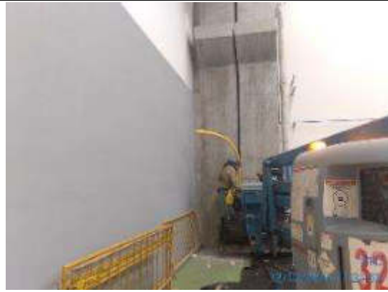
Foto 22.- Sellado de juntas de pilares en módulo #1.
