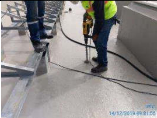
Foto 27.- Se realiza perforaciones en losa de cubierta de edificio administrativo para eliminar agua atrapada entre el mortero de pendientes y losa de hormigón.
