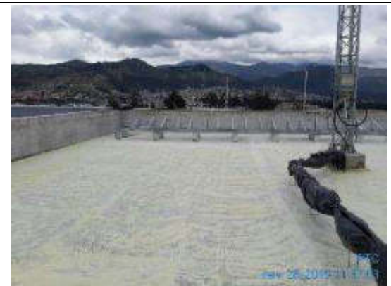
Foto 8.- Trabajos de impermeabilización de cubierta de edificio administrativo.
