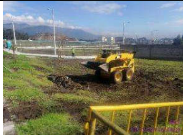
Foto 22.- retiro de escombros vegetales de urbanización quebrada El Carmen- Pumapungo.
