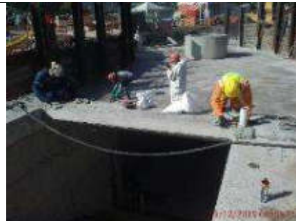
Foto 17.- 19/12/2019. Instalación del precerco del acceso 1.
