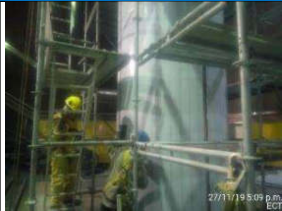
Foto 2.- Colocación de chapas de acero inoxidable espesor 2 mm recubrimiento de pilas pilote.
