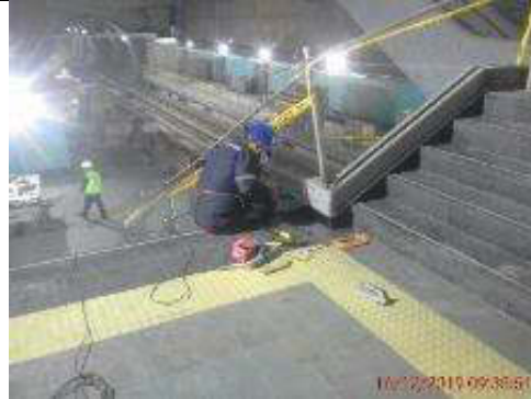
Foto 16.- 16/12/2019. Instalación del revestimiento del soporte inferior de los antepechos de borde de losa.
