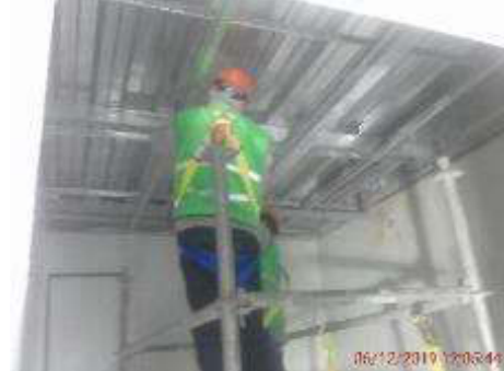
Foto 10.- 06/12/2019. Instalación de cielo falso de los vestidores a nivel de entreplanta.
