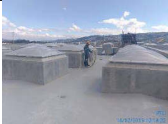
Foto 29.- Se realiza perforaciones en losa de cubierta de edificio administrativo para eliminar agua atrapada entre el mortero de pendientes y losa de hormigón.
