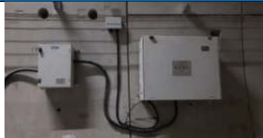
FOTO 02: 27-11-19.- Instalación de las cajas eléctricas para los engrasadores.
