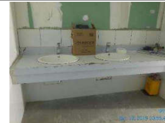
Foto 32.- Colocación de encimeras en cuartos de baño de segunda planta de edificio administrativo.
