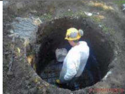
Foto 14.- 16/12/2019. Armado de acero del pozo de registro PZ2.
