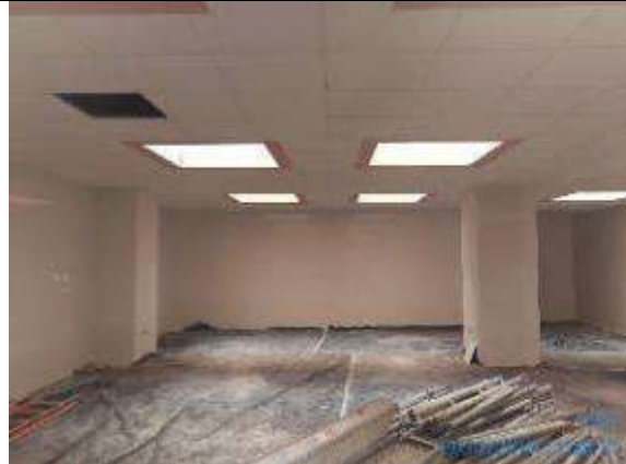
Foto 36.- Colocación de falso techo en planta alta de edificio administrativo.
