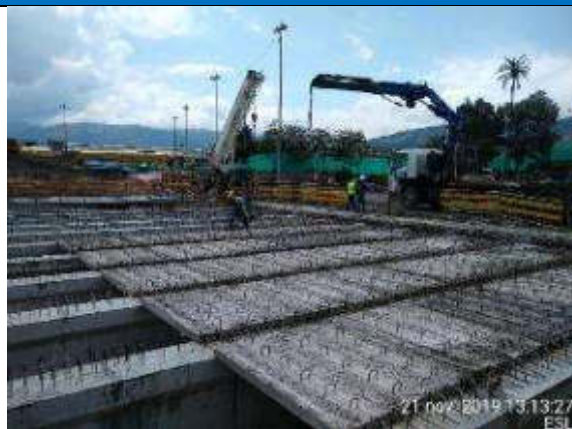
Foto 1.- Colocación de preciosas en las vigas prefabricadas AASTHO tipo IV ejes 1-2.
