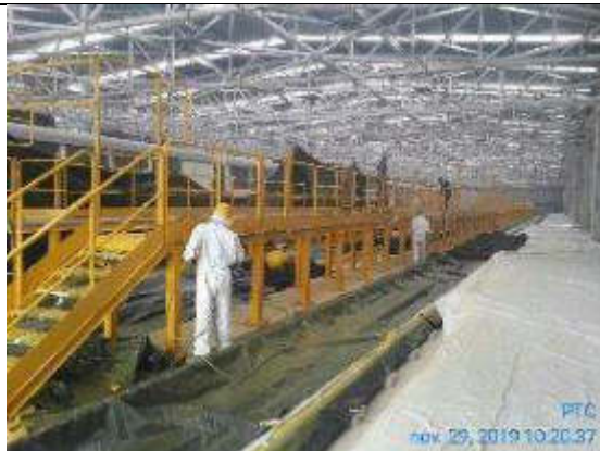
Foto 9.- Montaje de estructura metálica en vías de estacionamientos.
