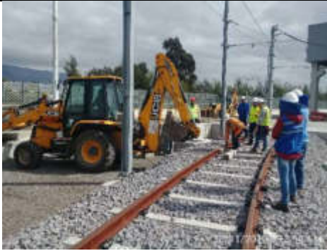
FOTO 01: 28/11/2019. Início de los trabajos de ajustes de las vías sobre balasto con la colocación de bridas en las juntas de carriles.
