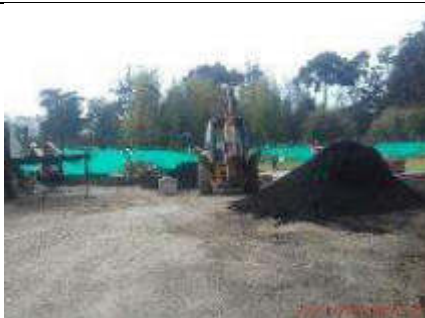
Foto 5.- 29/11/2019. Colocación de capa de tierra vegetal previo al sembrado de césped.
