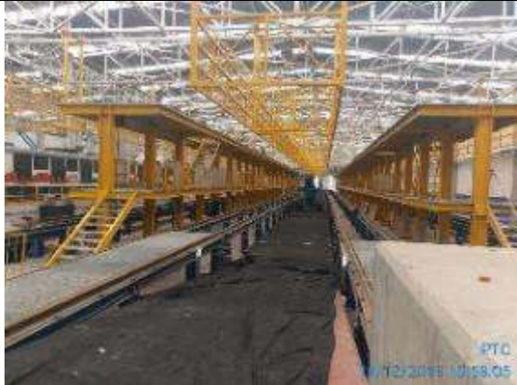
Foto 35.- Trabajos en estructura metálica de vía de mantenimiento.
