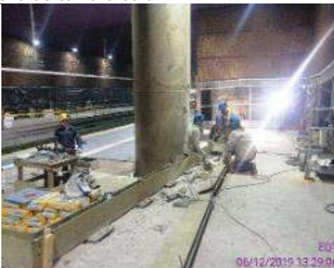
Foto 12.- soldado de zócalos de antepecho en rampa eléctrica
