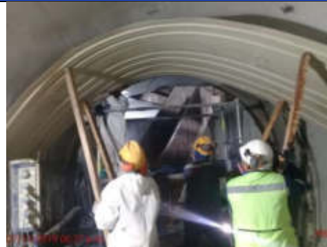
Foto 2 Instalación de lamas ignífugas.
