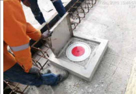
Foto 2.- Conformación de fillos para tapa de arqueta con cubierta metálica, para accionamiento mecánico.
