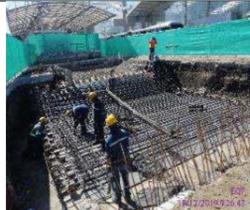
Foto 8.- armado de acero de losa de cubierta de acceso 2
