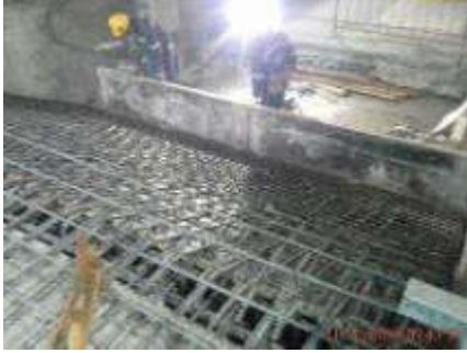
Foto 1.- 21/11/2019. Encofrado de las escaleras del acceso 3.
