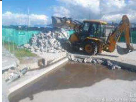
Foto 7.- Retiro de hormigón de protección de superficie de campamento en acceso 10
