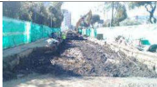
Foto 4.- RELLENO DE RAMPA DE VACIADO
