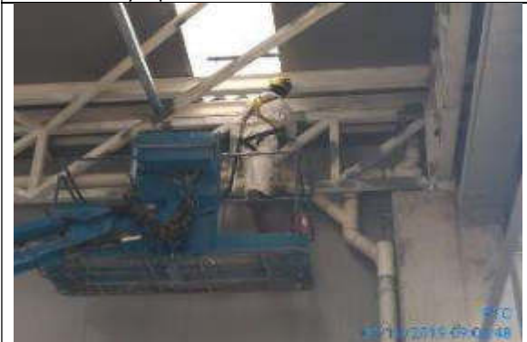
Foto 17.- Trabajos de reparación de pintura de estructura metálica de cubierta.
