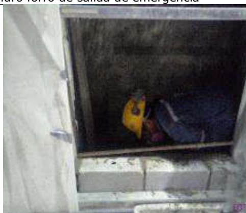
Foto 10.- enfoscado de cuarto de limpieza en zona de cámara bufa
