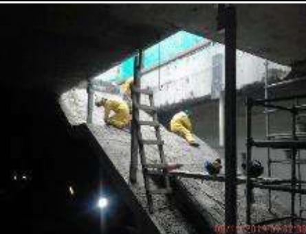
Foto 11.- 09/12/2019. Soldado de la perfilera vertical de las paredes lateral del acceso 3.
