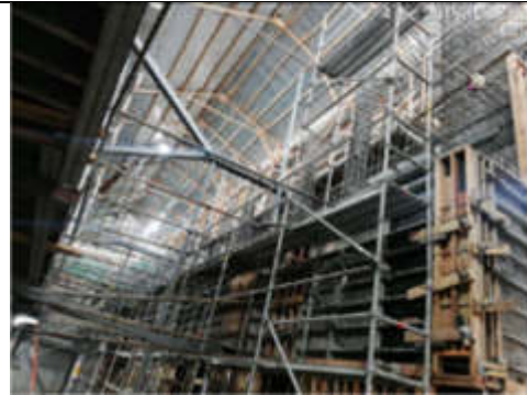
Foto 14.- 04/12/2019. Armadura de 3er tramo de muro interior
