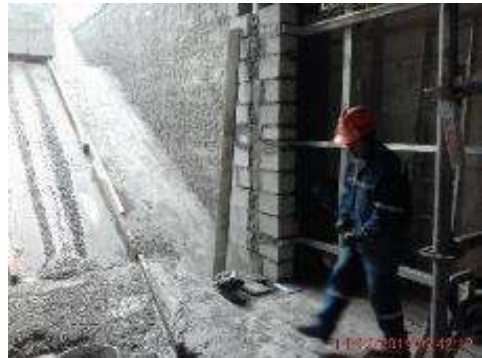
Foto 15.- 14/12/2019. Enfoscado de la mampostería del acceso 3.
