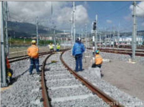
FOTO 05: 05/12/2019. Levantamiento topográfico de las vías 11 a la 26.
