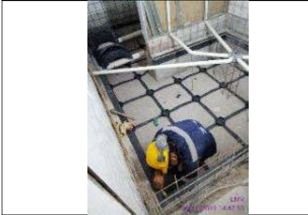
Foto 5.- colocación de cuplex Rialto en aseos de entreplanta
