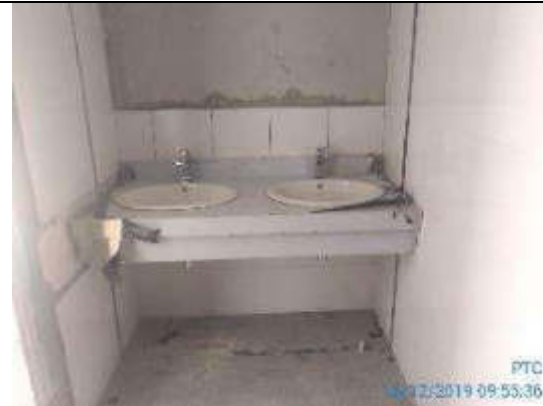
Foto 28.- Colocación de encimeras en cuartos de baño de segunda planta de edificio administrativo.
