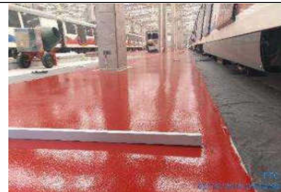
Foto 12.- Trabajos de TEIMPAV en área de mantenimiento.
