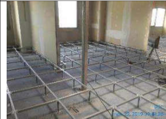
Foto 3.- Instalación de perfilera de suelo técnico en planta alta de edificio administrativo.
