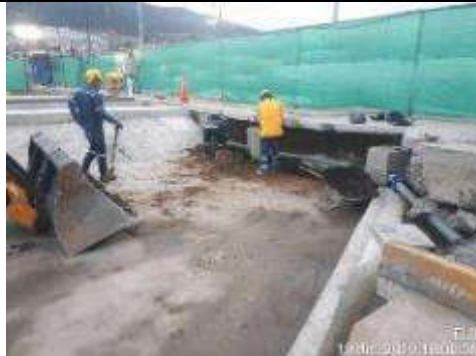
Foto 8.- Preparación de superficie para impermeabilización de cubierta de acceso 10
