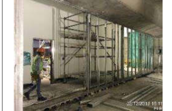
Foto 8.- Colocación de estructura tabiquería drywall en cuarto disponible a nivel losa de entreplanta.
