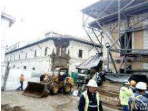
Foto 17.- 07/12/2019. Limpieza general de obra a maquina
