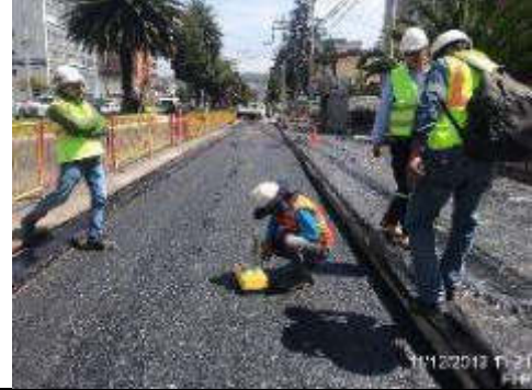
Foto 1.- Montaje y soldadura de casetón de ascensor nivel superficie Av. Eloy Alfaro Inglaterra. Foto 2.- Ensayo de densidades en tendido de carpeta asfáltica pavimento de rodadura Av. Eloy Alfaro.
