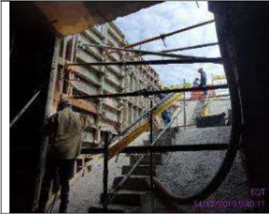
Foto 5.- encofrado de muro en "u" de salida de emergencia
