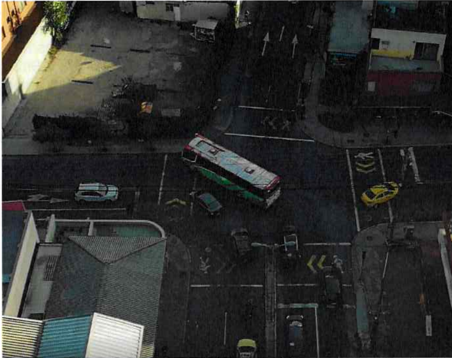
Radios de curvatura insuficientes, conflicto bus-liviano en giro izquierdo.
