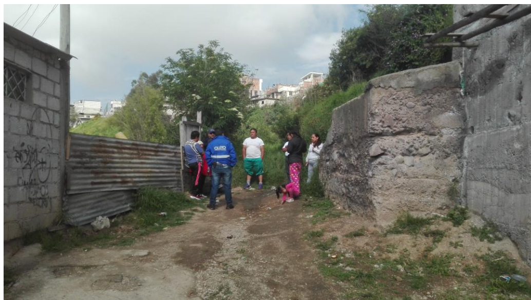
Inspección Zonas de Riesgos Comité del Pueblo
