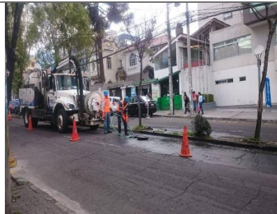
Destaponamiento de sumidero Veintemilla y Plaza
