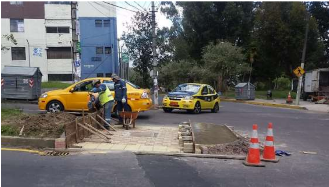
Intervención accesibilidad universal, cruce peatonal Av. Fernández Salvador / Fuente: GOM
