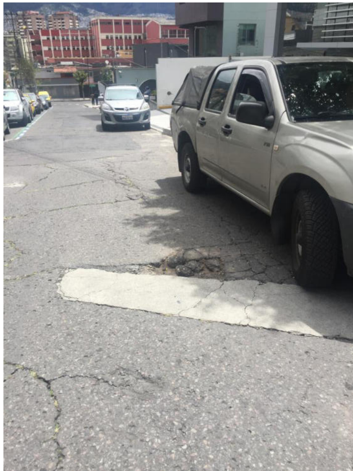
Ilustración 6: Bache en la Salazar y Destruje
