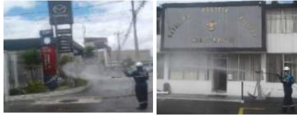
Descontaminación de instalaciones del CACMQ y varios espacios Públicos
