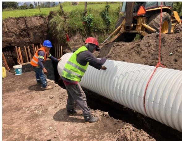
Foto 2: Canalización de aguas lluvia
