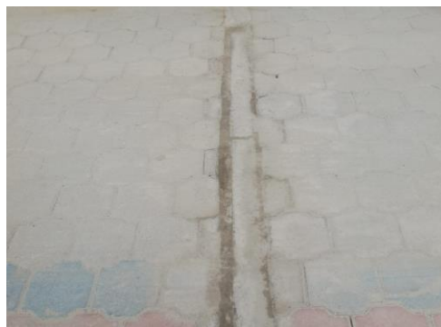
Se debe realizar el arreglo de la rejilla y su acometida que se encuentra destruida, cambiar los adoquines rotos, corregir el emporado, reparación de fisura en bermas, corregir espaciamento de adoquín, corregir fisura en los pozos.
