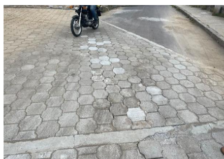
Corregir Hundimientos, retirar el exceso de emporado y reparacion de pozo
