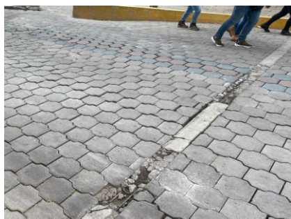
Se debe realizar el arreglo de la rejilla y su acometida que se encuentra destruida, cambiar los adoquines rotos, corregir el emporado, reparación de fisura en bermas, corregir espaciamento de adoquín, corregir fisura en los pozos.
