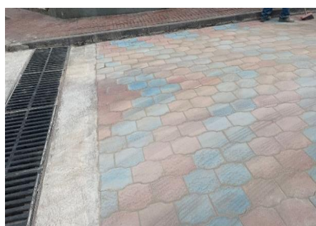
Cambiar adoquín roto, reparación de berma, enlucido rejilla y colocar sumidero
