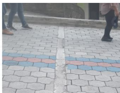
Corregir el espaciamento de los adoquines en la parte central, cambio de adoquines rotos, corregir berma, corregir emporados.
