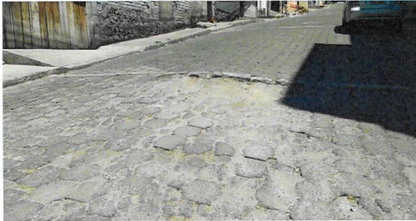
Fig. 2. Calle Ramírez de Arellano, Barrio Pavón Grijalva, Parroquia San Juan
