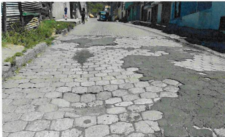
Fig. 4. Calle Ramírez de Arellano a la altura de Oe17A, Barrio San Salvador, Parroquia San Juan
