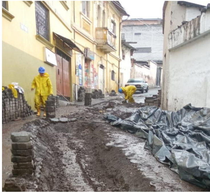
Protección de material
