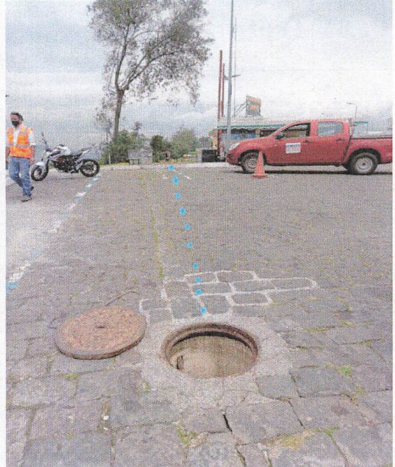
ZONA DE INSPECCIÓN
