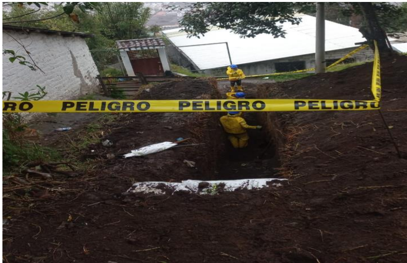
Señalización en zanjas
