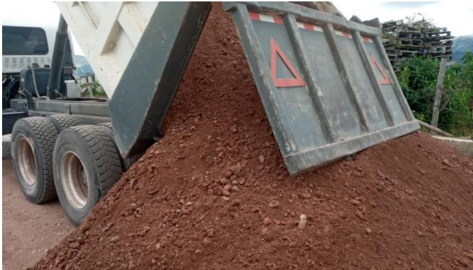
Fotografía 1: Entrega de material Sub Base Clase 3
