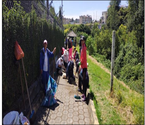
Ilustración 2. Limpieza de basura y escombros
